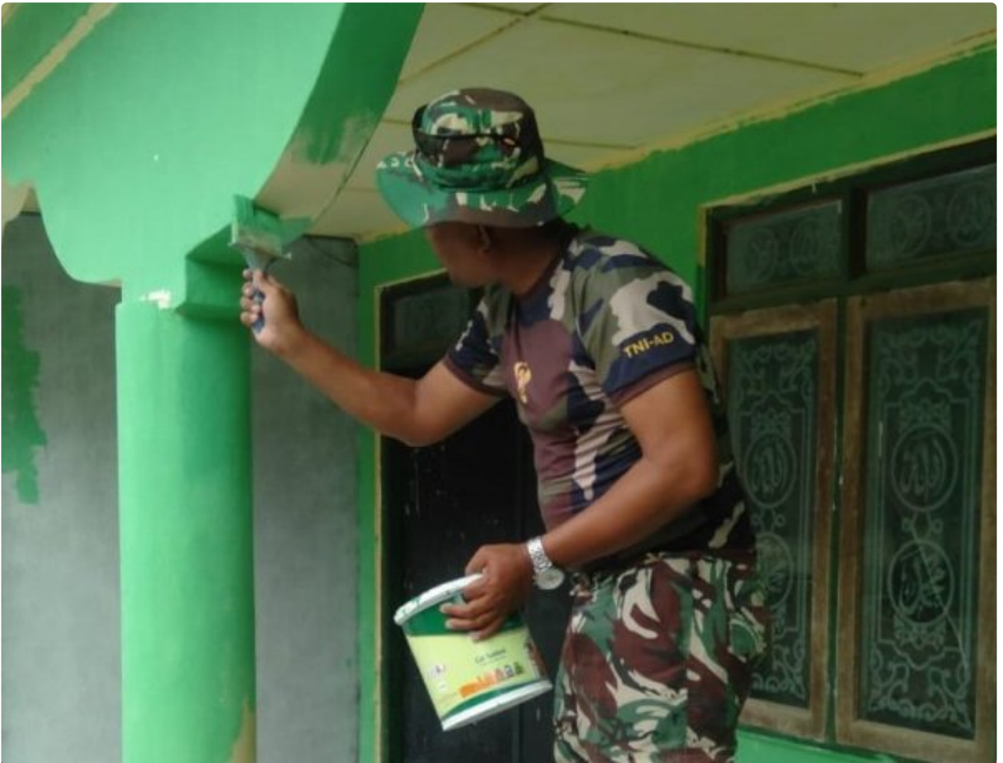
Satgas TMMD Lakukan Pengecatan Finishing Rehab Mushola Di Desa Cangkring
